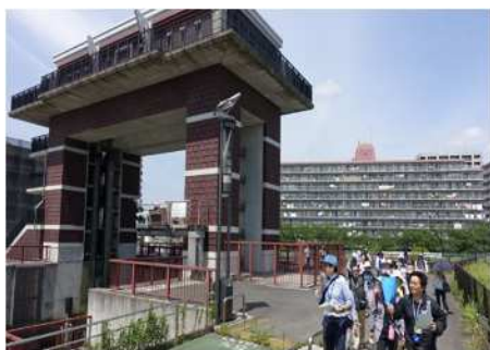
荒川ロックゲート
