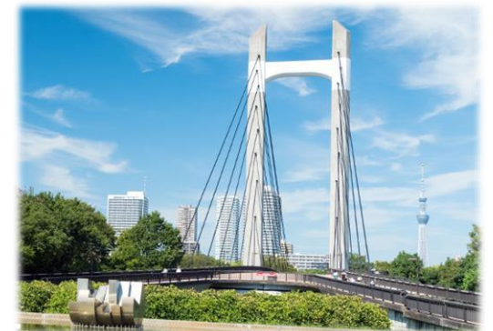
長寿命化計画の対象となる公園橋
