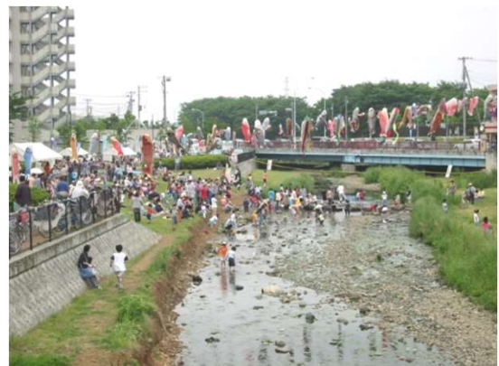
親水性に配慮した緩傾斜護岸の整備 空堀川 (東村山市美住町付近)
