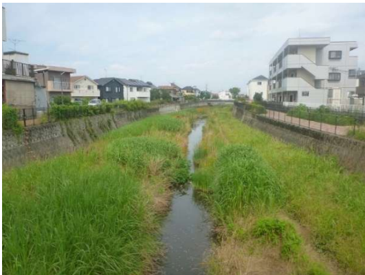
拡幅整備した空堀川 (東大和市奈良橋付近)
