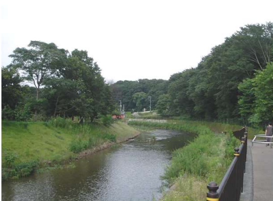
河畔林を保全した護岸の整備 柳瀬川 (清瀬市下里付近)
