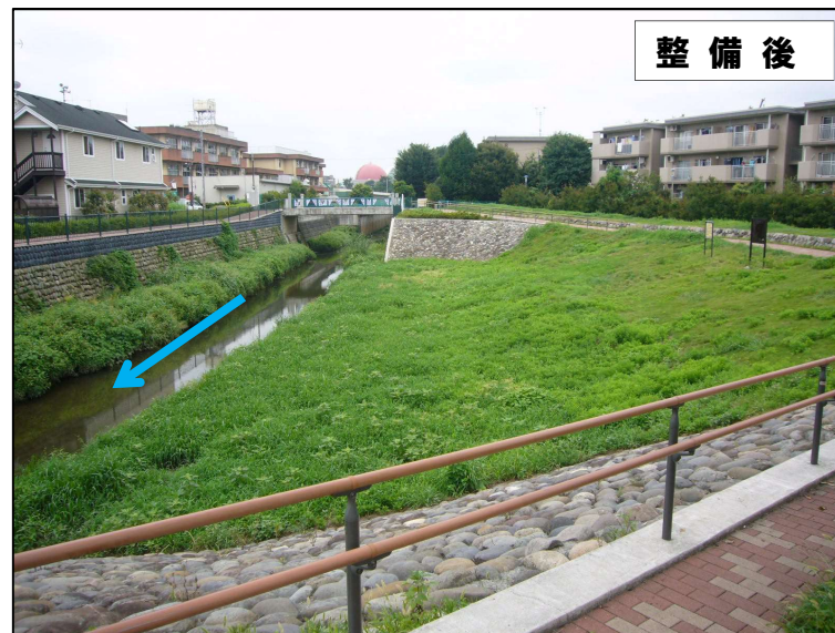
緩傾斜護岸の整備により親水性のある水辺を形成
