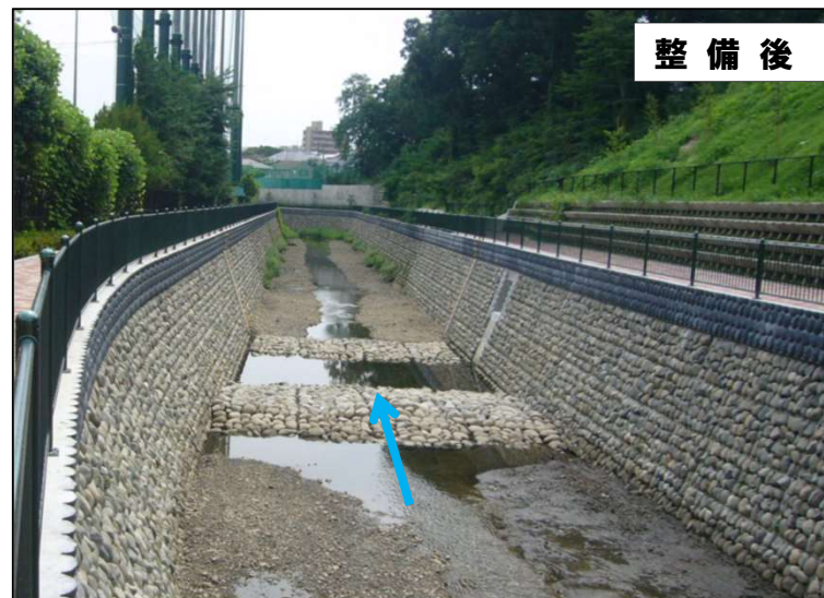
河道拡幅による流下能力の向上
