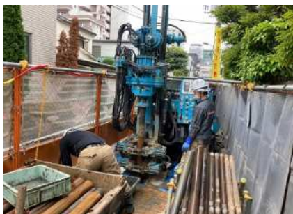
ボーリング調査状況
