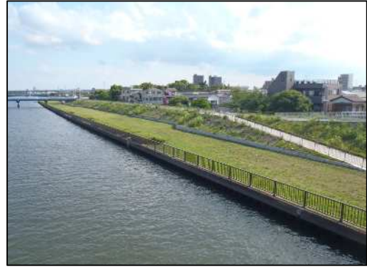
新中川低水護岸・高水敷整備【整備後】
