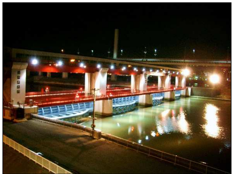
東日本大震災で閉鎖した上平井水門（夜間）
