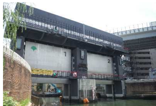
豎川水門（耐震工事完了後）
