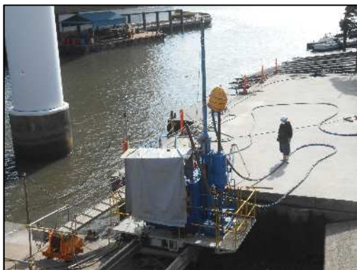
【地盤改良施工中】
