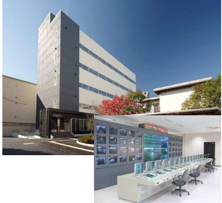
水門管理センター
