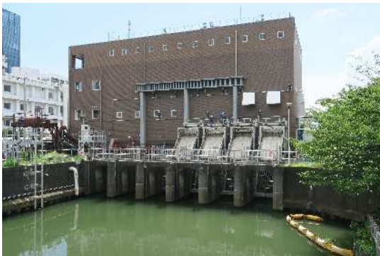
新川排水機場（耐震対策後）
