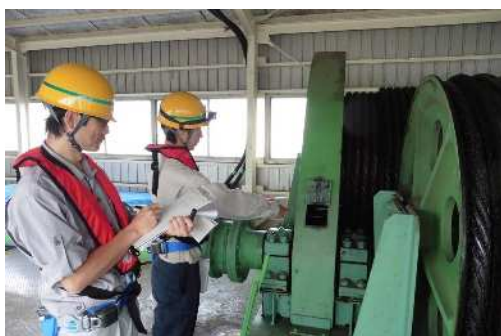
水門上屋設備点検
