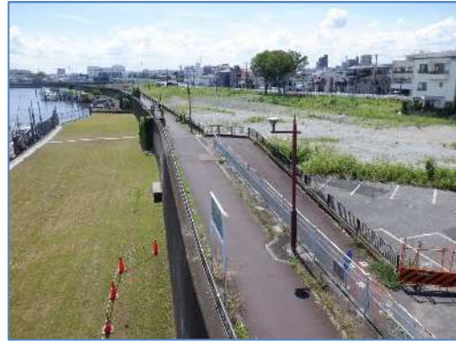
江戸川四丁目地区【施工前】
