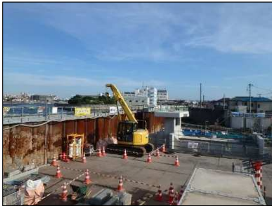
(施工状況：新川右岸側)
