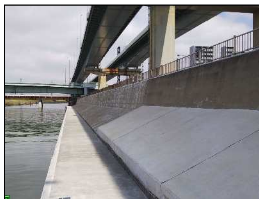
綾瀬川 新四つ木下流【完了】
