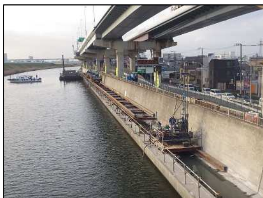
綾瀬川 四ツ木小橋上流【施工中】
