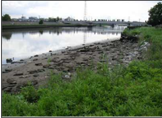
新中川低水護岸整備【整備前】
