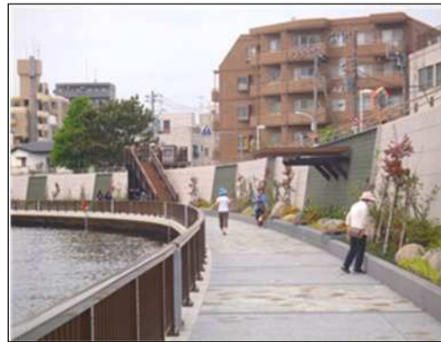
中川護岸（七曲区間）【施工後】
