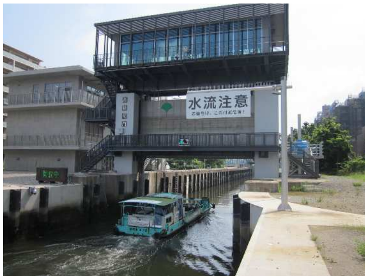
扇橋閘門の全景
