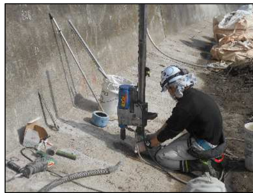
【せん断補強施工中】
