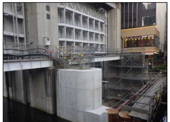
(施工状況：内水側左岸)
