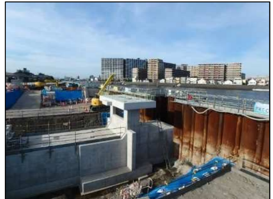
(施工状況：新川左岸側)
