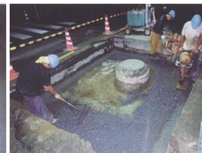
発見された空洞の復旧
