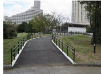
段差解消の状況
