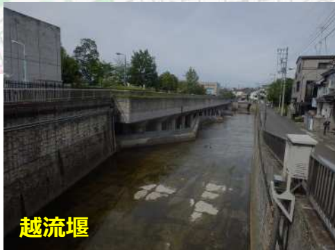
越流堰（対岸より）
