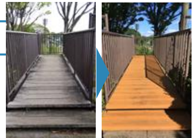
老朽化した公園の施設をリノベーション (陵南公園)
