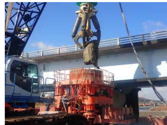
③ コンクリート基礎撤去
