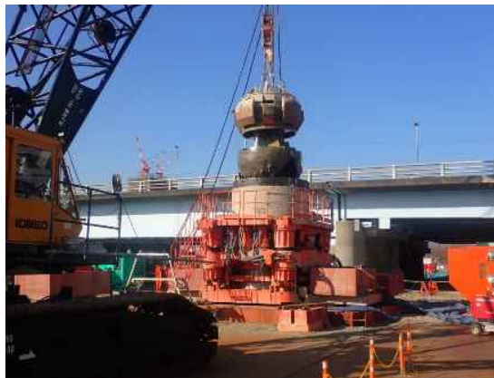
② 油圧グラブ掘削
