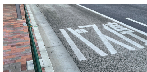
写真 1-1 半たわみ性舗装施工例
