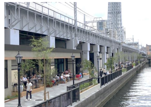
（取組例）まちづくりと連携した河川整備
