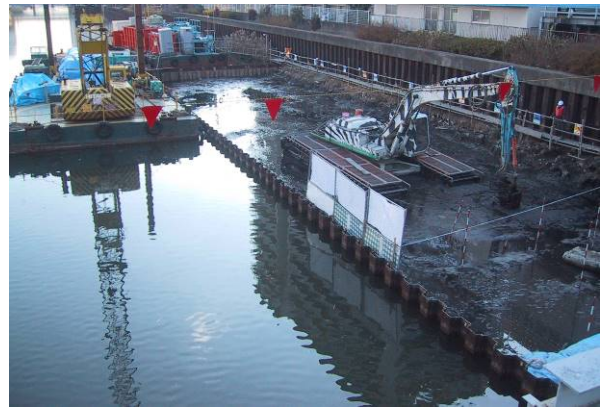
写真一1 固化処理状況（ロータリー式攪拌工法）
