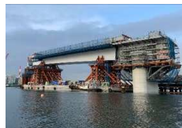
写真-5 上部工台船架設
