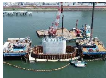
写真-4 鋼管井筒矢板基礎工
