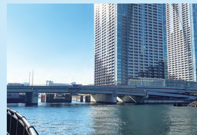
黎明大橋の状況 (R 2.12)
