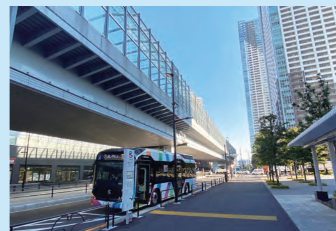
勝どき陸橋の状況 (R 2.12)
