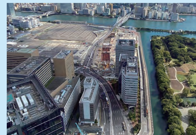
築地地区全体の状況 (R 2.10)
