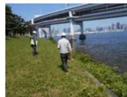
セキュリティカメラ 設置立会
