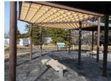
パーゴラ・ベンチ補修工事
