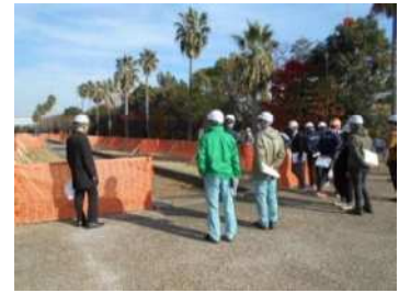
南側撤去工事の完了、引渡し立会
