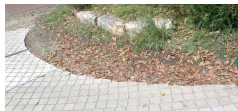
駐車場横入口のスロープはタイル欠損部をモルタルで補修、雨水を浸透する防草土で水たまりを解消
