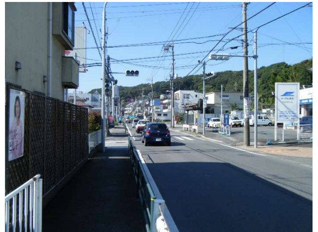
Ⅱ期起点部よりⅠ期終点部をのぞむ
