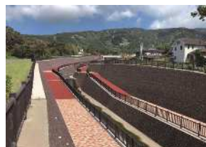
大金沢流路工
