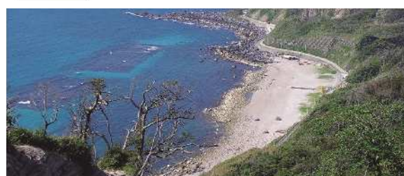
人工リーフ (海面下に設置する離岸堤) の整備 (神津島 長浜海岸)
