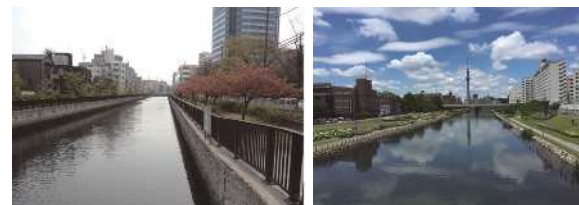
耐震護岸整備 (大横川)
