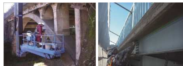
橋梁の点検状況 コンクリート補修状況
