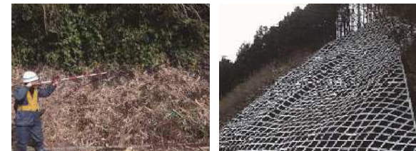
斜面の点検状況 法枠による斜面対策
