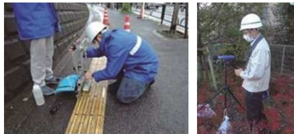
路面すべり抵抗調査
