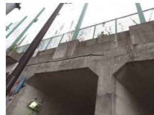
擁壁のひび割れ対策調査
