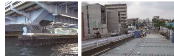
支承補強後 床版取替後
