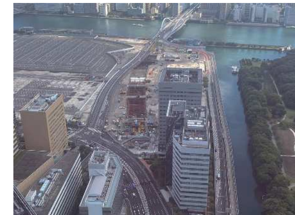
環状第2号線（築地地区）
