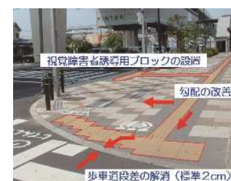
バリアフリー化整備事例 尾久橋通り(足立区扇)
