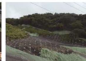
大金沢山腹工
