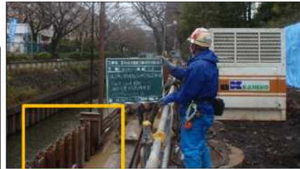
鋼矢板（イメージ写真）
