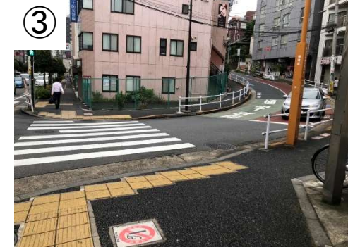
③ 中間部(取付道路部)
