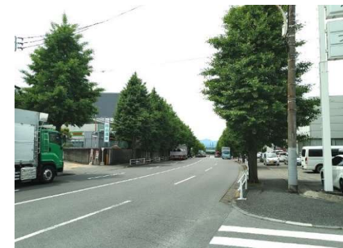
(整備済み区間の状況)
