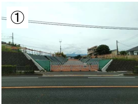
起点側(石川町側)
