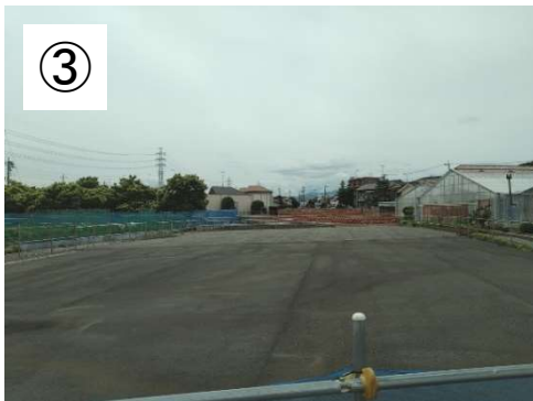
道路予定地(宇津木町側)
