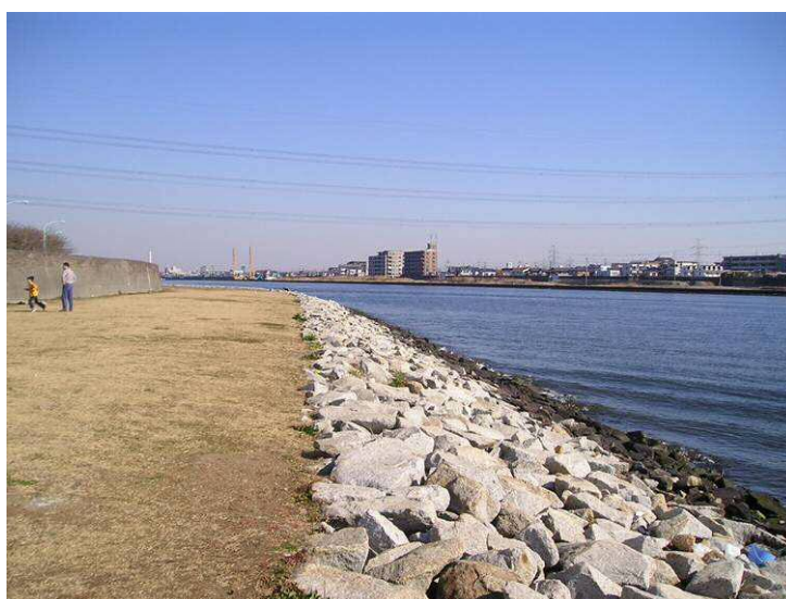
低水護岸(捨石)整備例(旧江戸川)
