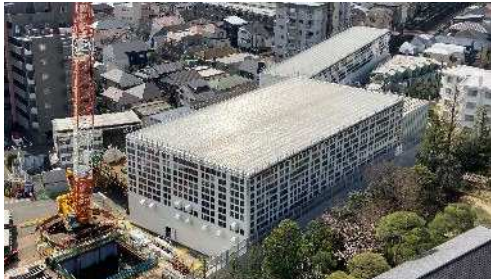
妙正寺川取水施設の防音ハウス
