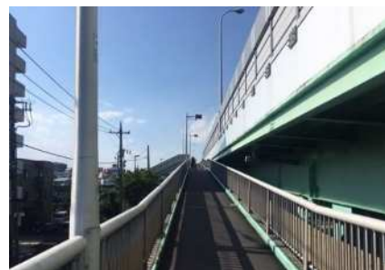
長いスロープの例 青砥橋（葛飾区）
