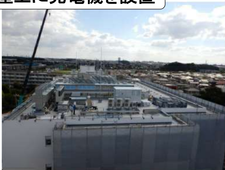
屋上に発電機を設置
