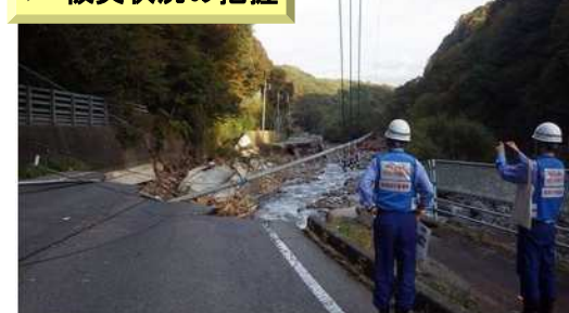
【令和元年東日本台風】 (群馬県嬬恋村)
