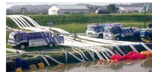
排水ポンプ車による排水活動
