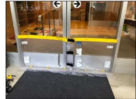
▲区有施設の浸水対策検討（港区）
