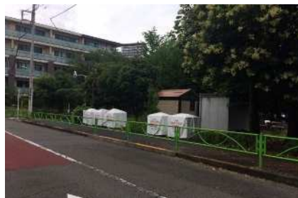
▲土のう保管箱の整備 (目黒区)
