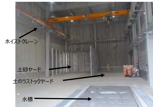
▲大田区仲六郷水防資機材センターの建設 (大田区)
