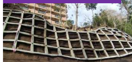
急な斜面を保全する法枠工
