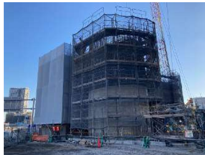
換気所の施工状況
