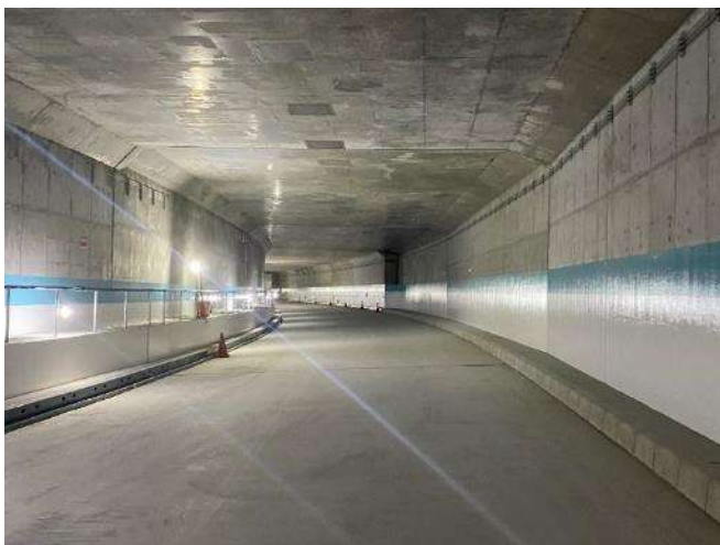
トンネル躯体の施工状況 (令和3年11月撮影)
