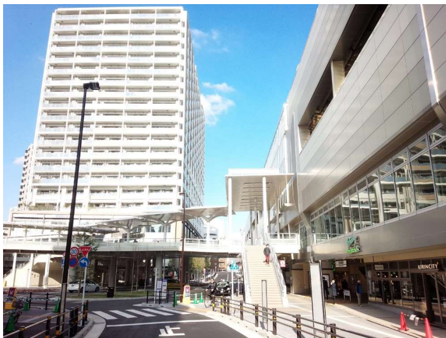
京浜急行本線・空港線 京急蒲田駅
