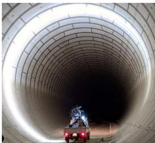
図18 走行型画像計測の実施状況写真
