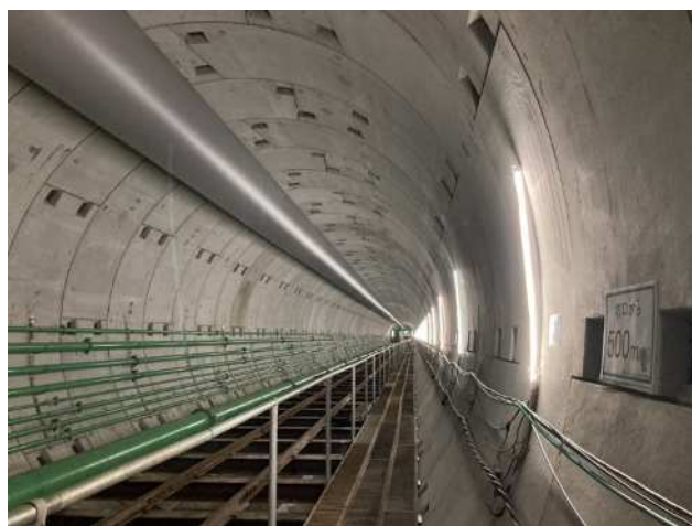
掘削済みの分水路トンネル内部
