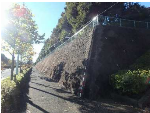
擁壁：ブロック積み擁壁
