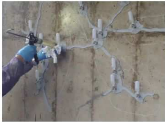
図-8 ひび割れ修繕イメージ
