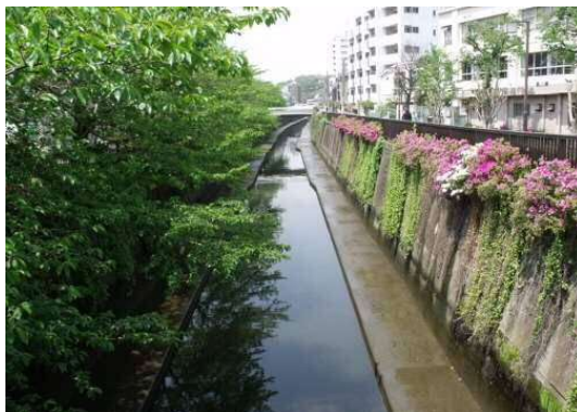
写真4-1 護岸の緑化整備例（日蓮橋付近）
