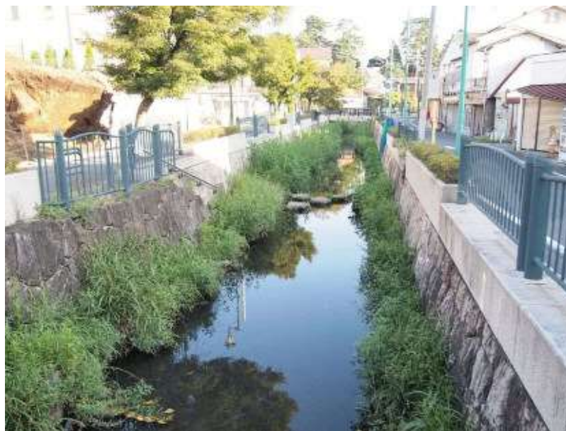
写真 4 - 1 護岸緑化状況 (大田区)
