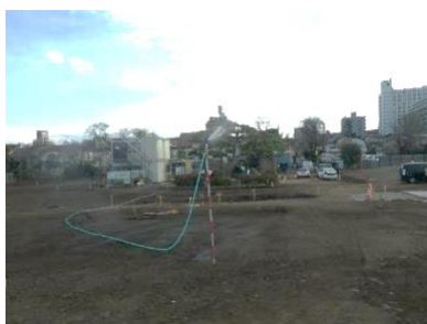
スプリンクラーによる散水状況
