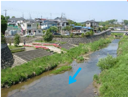
かすが 春日橋上流側
