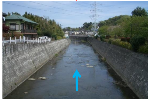
しょうじんば 精進場橋下流側
