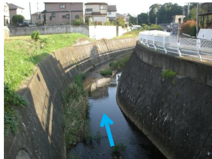
さかした 坂下橋下流側
