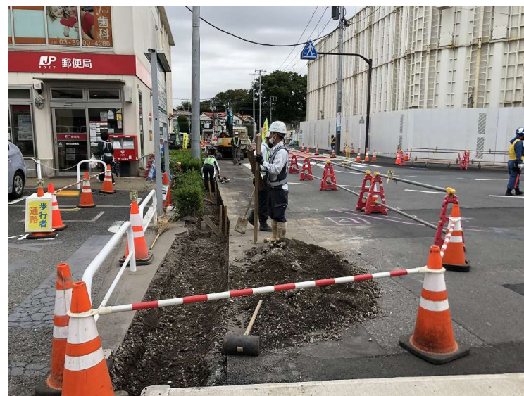
【道路整備工事状況(令和3年9月撮影)】
