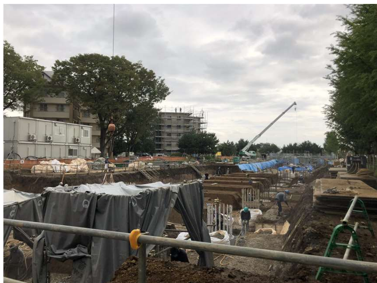
【団地建設工事状況(令和3年9月撮影)】
