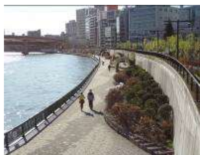
テラス整備状況 (隅田川)
