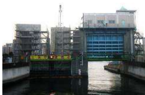
水門の耐震対策（大島川水門）
