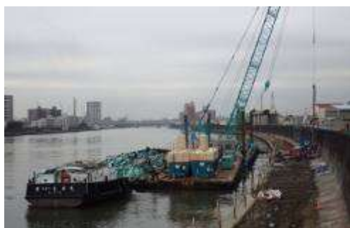
堤防の耐震対策（隅田川）
