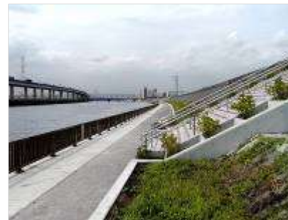
耐震対策後(中川)
