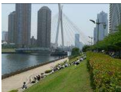
スーパー堤防 (隅田川新川地区)
