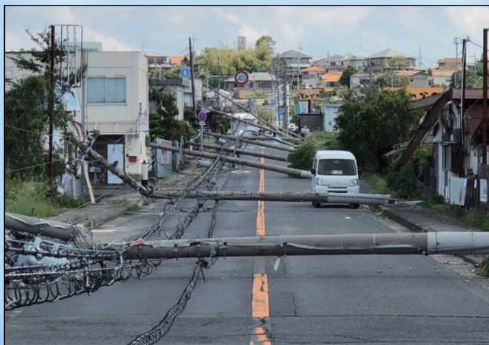
平成30年台風第21号(大阪府泉南市)
