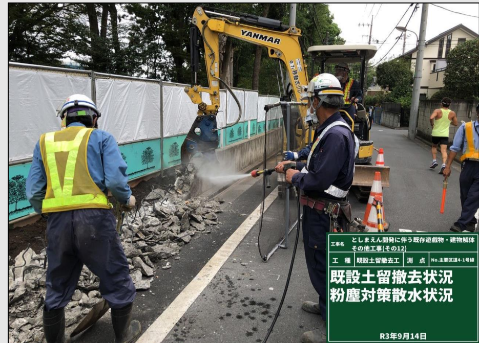
ホースによる散水
