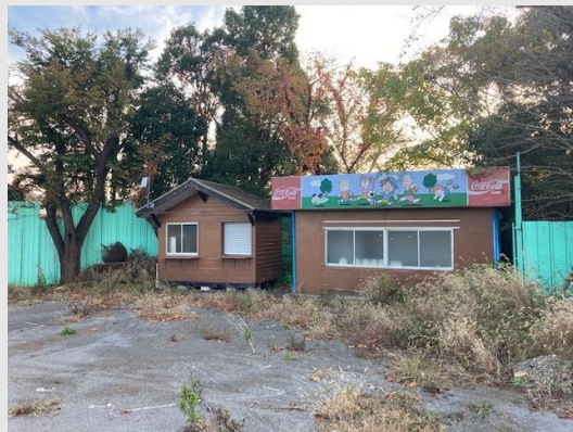
小規模構造物（詰所）
