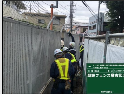
フェンス撤去（イメージ）
