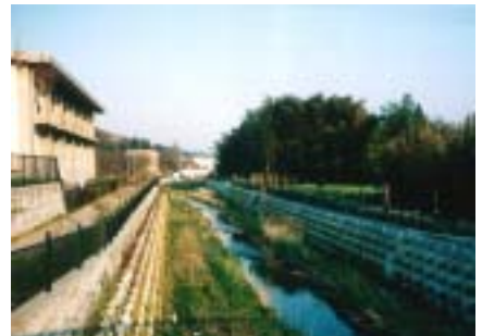
拡幅整備した谷地川 (八王子市加住1丁目)
