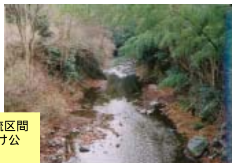
既に整備された区間 (川口川：佐貫橋下流)
