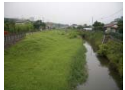
旧河川敷を利用して 緩傾斜護岸を整備 (谷地川)
