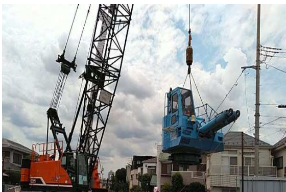
クランプクレーン解体
