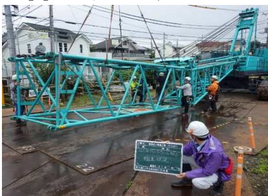
【1】クローラクレーン組立イメージ
