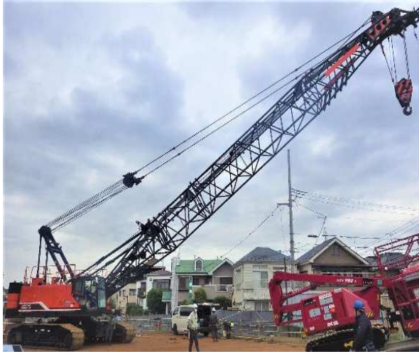
※ 前回工事写真
