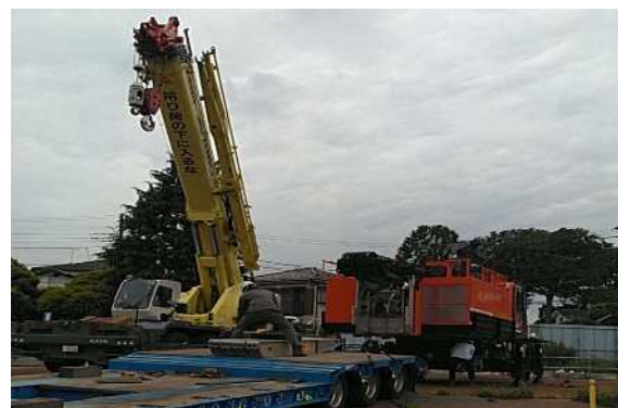
クローラクレーン解体
