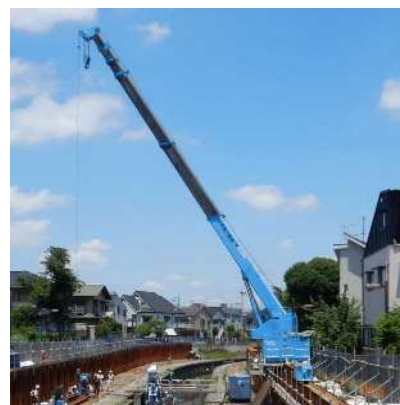
【2】クランプクレーン設置イメージ
