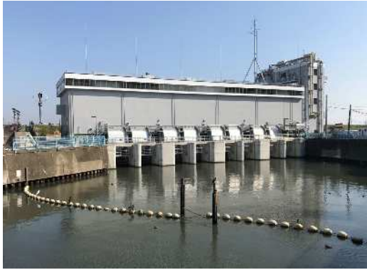
小名木川排水機場（耐震対策後）
