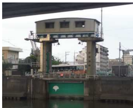
(着手前：外水側全景)
