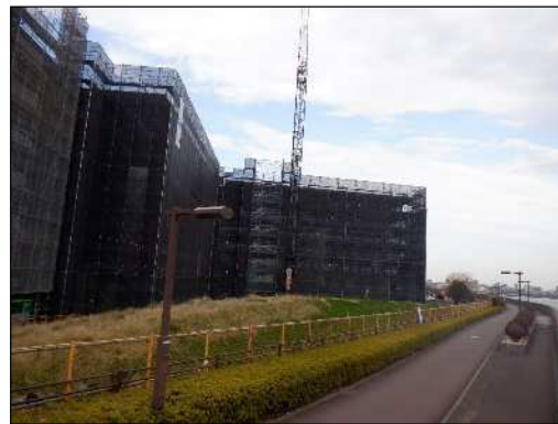
東葛西九丁目地区【施工中】
