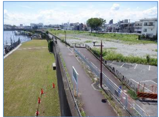
江戸川四丁目地区【施工前】
