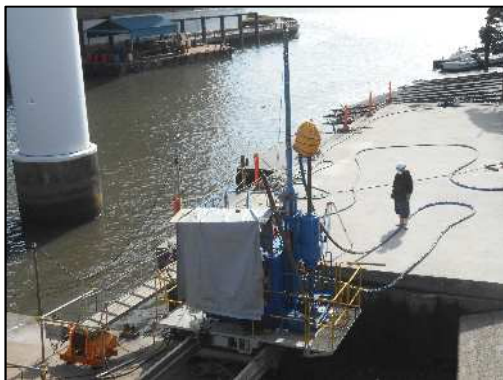
隅田川防潮堤耐震補強工事
