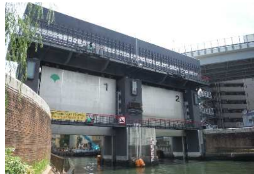
豎川水門（耐震工事完了後）
