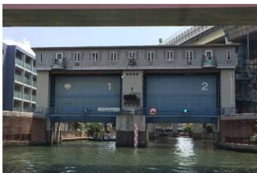
豎川水門（耐震工事施工前）
