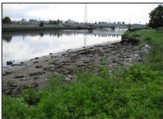
新中川低水護岸整備【整備前】
