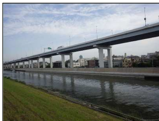
綾瀬川東四つ木避難橋下流【完了】
