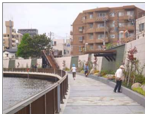
中川護岸（七曲区間）【施工後】
