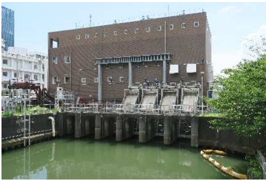
新川排水機場（耐震対策後）
