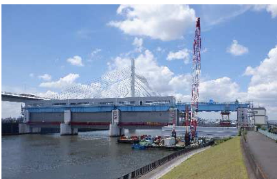
(施工状況：外水側全景)
