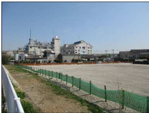
新田一丁目北地区【施工前】
