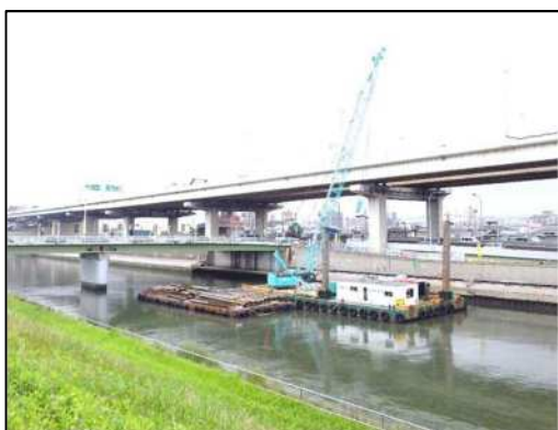
綾瀬川木根川橋下流【施工中】
