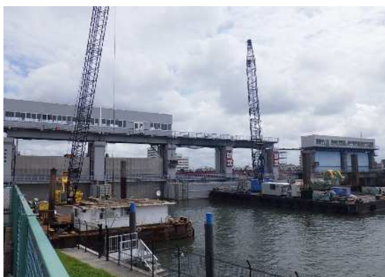
(施工状況：外水側全景)
