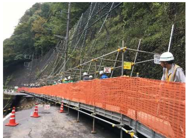
写真－2 仮設歩道の設置状況
