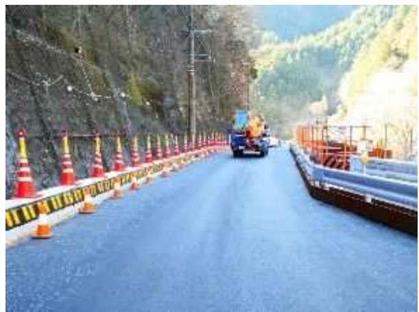
写真一4 復旧完了後の道路状況
