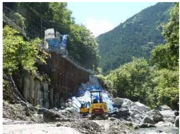
写真一3 自走式回転切削 圧入工法の施工状況
