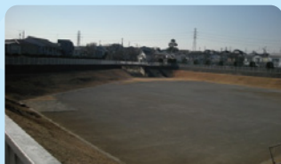
①芝久保調節池(西東京市)
