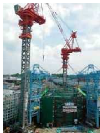
ケーソン工事(※2 到達立坑)
