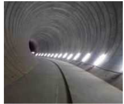
白子川地下調節池内部
