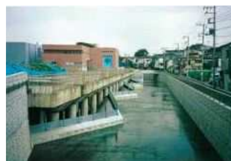
比丘尼橋下流調節池取水施設工事(※1)
