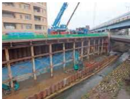
石神井川取水施設工事(※3)
