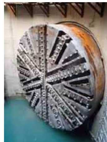
シールド工事(※2)
